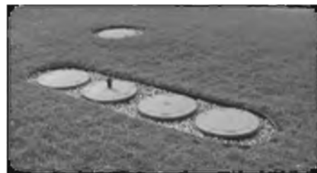
Photo 3 Couvercles en polyéthylène doivent être dévissés
